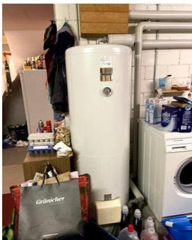
L'eau chaude sanitaire est produite au moyen d'un chauffe-eau électrique.
