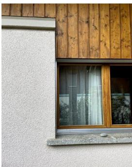
Les ponts thermiques identifiés se situent au niveau du socle du bâtiment entre la cave et le rez-de-chaussée, au niveau des raccords entre les murs et le plafond de la cave ainsi qu'au niveau des caissons de stores. Les fenêtres présentent des ponts thermiques habituels au niveau des embrasures de fenêtre. Les balcons sont construits en bois et ne présentent donc pas de ponts thermiques.
